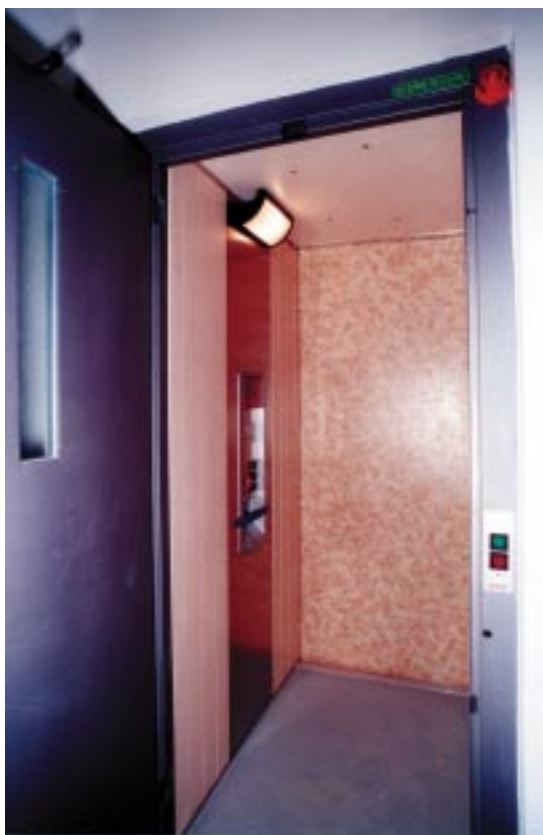
Interno della piattaforma elevatrice che collega il piano terra al primo piano
