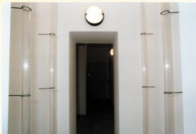
Primo piano, Tubolari in plexiglas per la protezione delle corde delle campane
